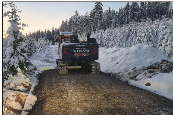
Den nye skogsbilvegen ved Svartåsløkka tar form.
