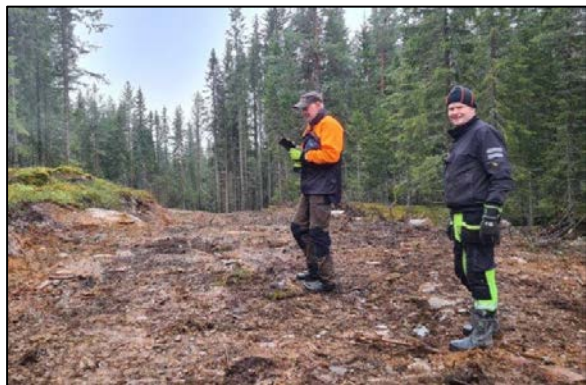
Befaring nye skogvegen ved Svartåsløkka
