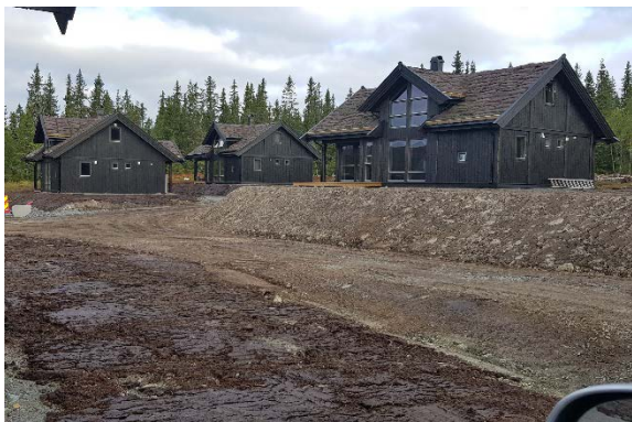
Ferdig planert terreng – Gutubakken
