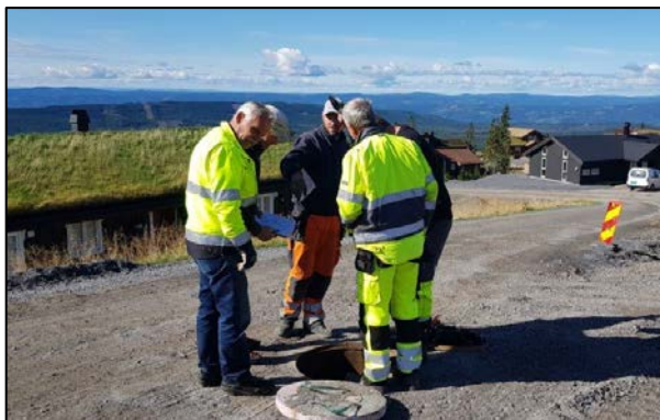
Befaring av vann og avløp i forbindelse med overdragelse av ledningsnett til kommunen
