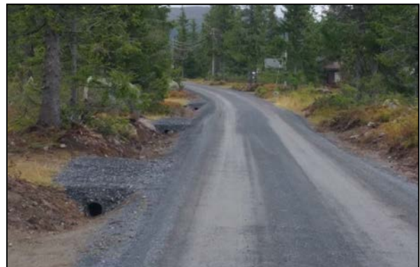
Ferdig oppgradert hytteveg på Vassbaken
