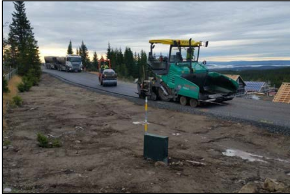
Asfaltering av Storkvanndalsveg ved Gutubakken
